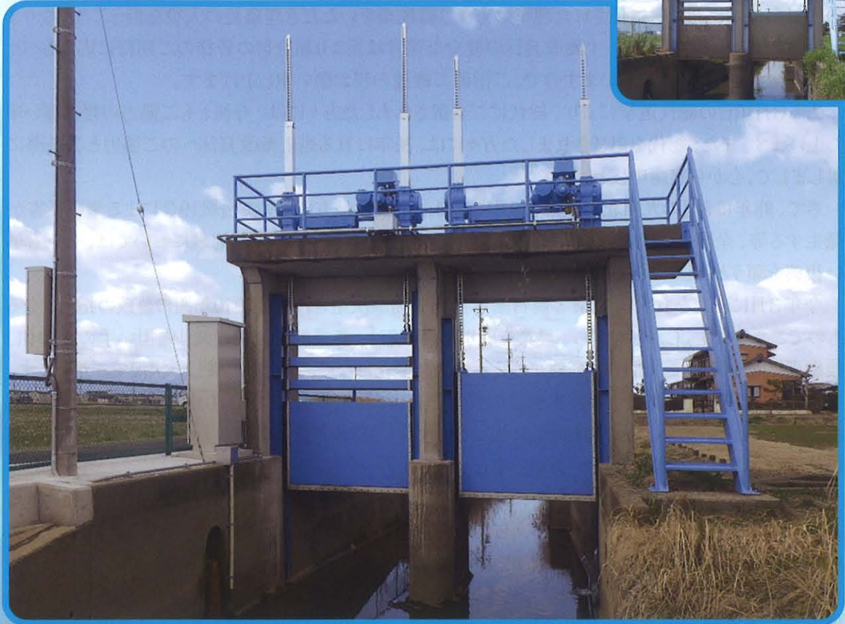
県営かんがい排水事業「松枝・足近2期地区」(足近北排水路下流樋門:羽島市足近町地内)
